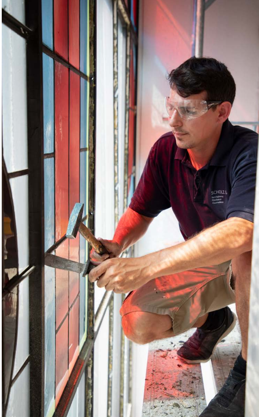
Patrick Scholz schlägt den Kitt vom Rahmen. Erst dann kann er die Glasscheiben herauslösen und in die Werkstatt zum Restaurieren bringen.
